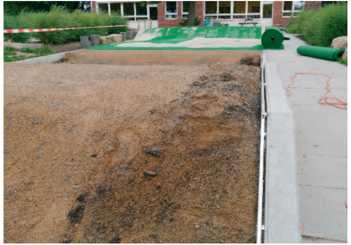
Einfassung des Teppichvlies am Borstein mit Hilfe von Metallschienen.
