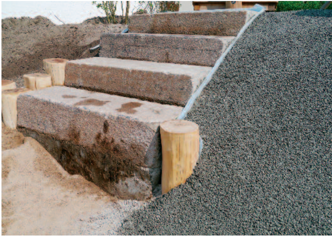
Erstellung einer Fuge in Einkornbetonfläche.
